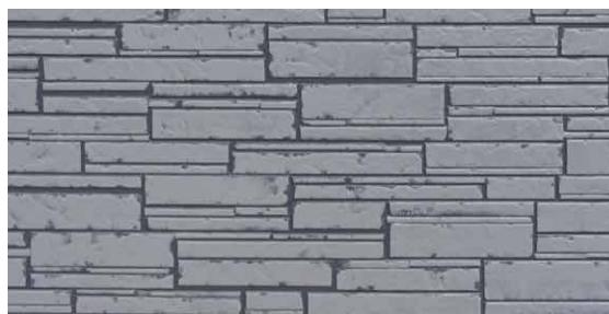
仕上げはサイディングの模様方向に動かすことで仕上がりが良くなります。塗り残し、塗り忘れはないかチェックしてください。ウルトラTOPは水性エマルジョンのため塗装面が白く見えることがあります、十分に乾燥させることにより透明になります。
