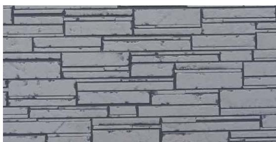
仕上げはサイディングの模様方向に塗装してください。膨れの原因になるため、塗装後は十分に乾燥させてください。
