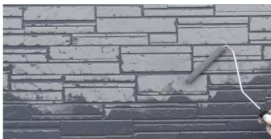
短毛ローラーで凸部にのみ塗装します。ローラーはサイディングの模様方向、または斜め方向に動かすことで目地部に塗料が入りにくくなります。
