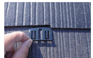
タスペーサーを挿入
