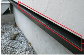
水切りの上に手を入れ、サイディングボードと断熱材の間に隙間があれば「通気工法」です。
