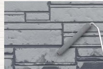
毛丈の短いローラーで表面(凸部分)を塗装していき、サイディングの意匠性を再現します。
