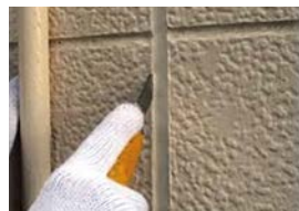
カッターでシーリング材の 左右両面を切る
