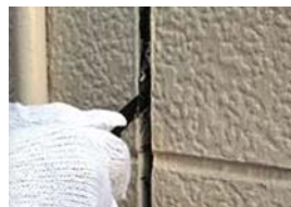
小口に残ったシーリング材を 丁寧に除去する
