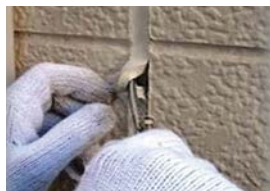
ドライバなどでシーリング材 を引っ張り出す
