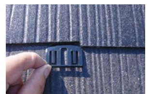
タスペーサーを挿入
