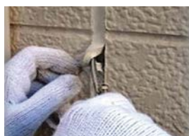
ドライバなどでシーリング材 を引っ張り出す
