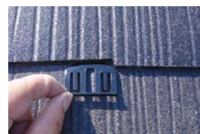
タスペーサーを挿入
