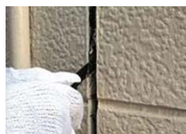
小口に残ったシーリング材を 丁寧に除去する
